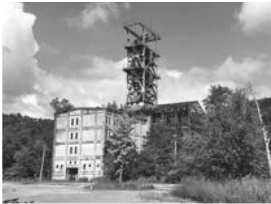
住友別墅坑槽
